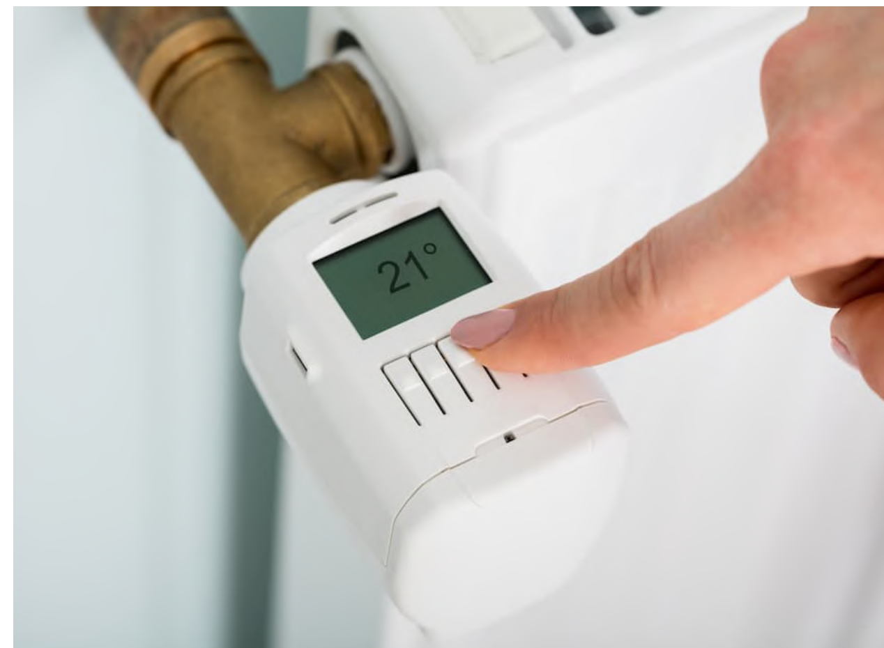
Elektronische Thermostate bieten eine präzisere Temperaturregelung im Vergleich zu mechanischen Thermostaten © Andrey Popov, stock.adobe.com
